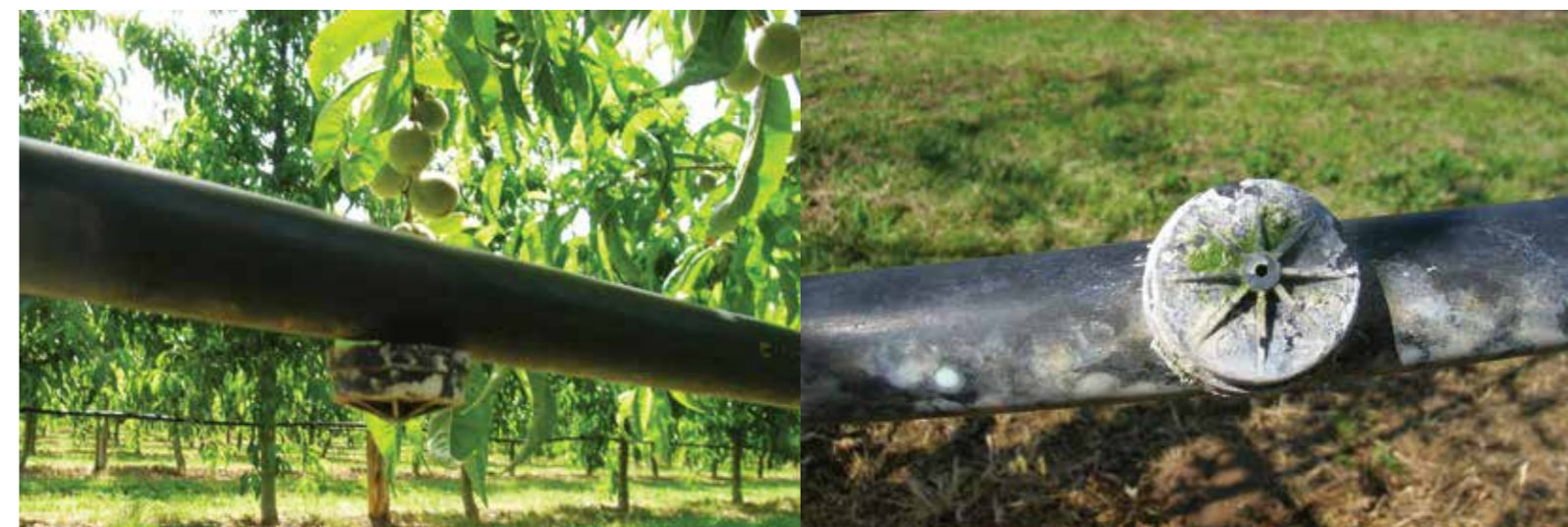
Due esempi di gocciolatori che si sono intasati.
